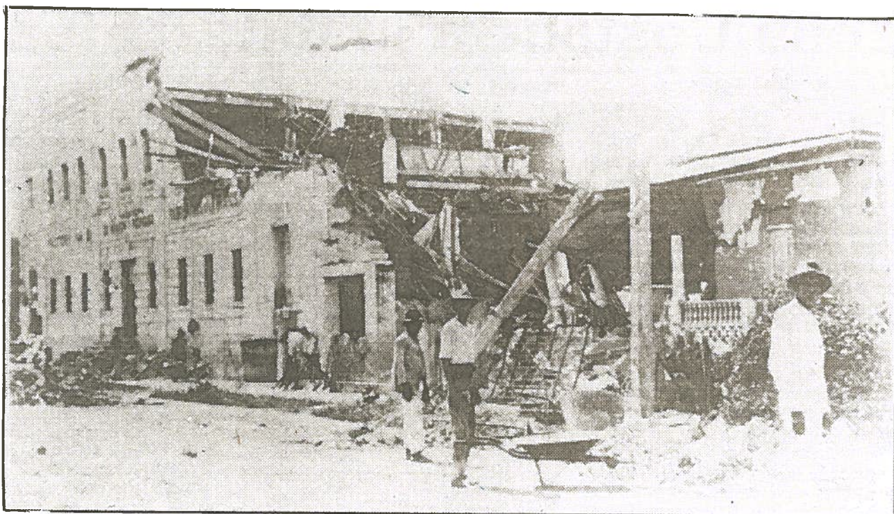
Vista parcial de una de las estructuras que quedó en ruinas luego del terremoto de 1918 en el área oeste de Puerto Rico.
