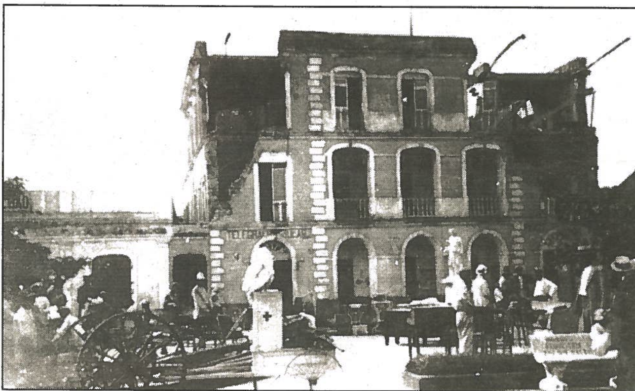
Efectos del terremoto del 1918 en el pueblo de Aguadilla.
