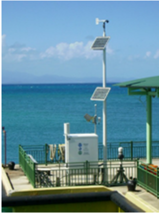
Estación mareógrafo de Vieques
