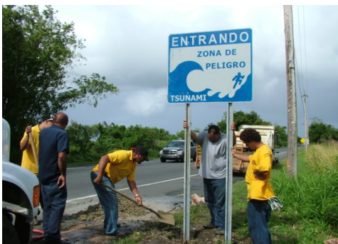
Instalación de rótulos de zonas vulnerables al efecto de tsunamis
