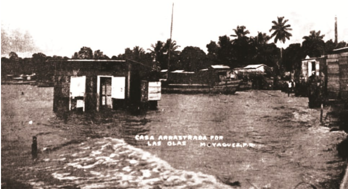
Figura 14 . Casa arrastrada por las olas del tsunami del 1918.
