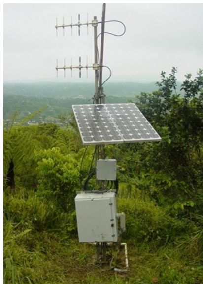
Figura 20. Estación sísmica de Yabucoa (RSPR-UPRM).
