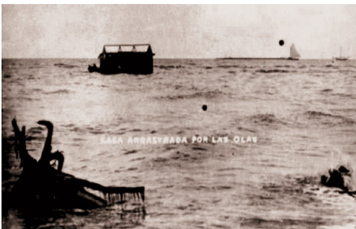
Figura 15 . Casa arrastrada por las olas del tsunami del 1918.
